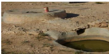
Vue d'ensemble d'une citerne pour la collecte des eaux pluviales dans une zone rurale
