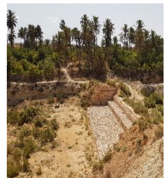
Vue d'ensemble des barrages de recharge en maçonnerie de l'oued Matmata et en gabion sur oued Sourrak à Gabes
