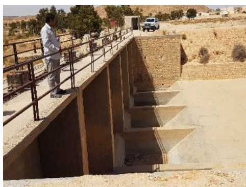
Vue d'ensemble des barrages de recharge en maçonnerie de l'oued Matmata et en gabion sur oued Sourrak à Gabes
