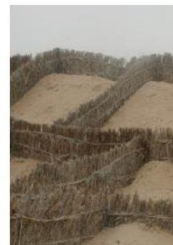
Protection de nouvelles oasis contre l'ensablement en utilisant des feuilles de palme
