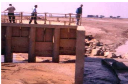
Vue d'ensemble d'un Mgoud construit avec du béton avec plusieurs ouvertures dans la zone de Sidi Bouzid
