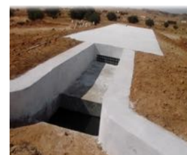
Vue d'ensemble d'une citerne pour la collecte des eaux pluviales dans une zone rurale
