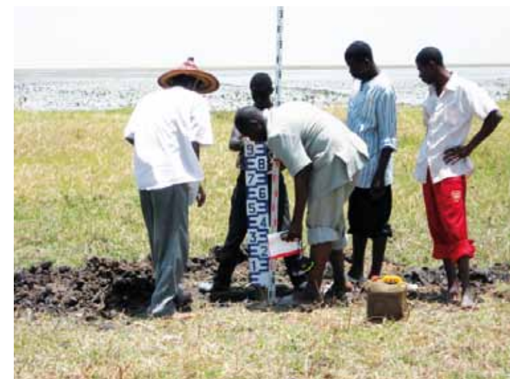
Travaux de nivellement topographique.
